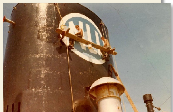
Vlnr. Matrozen Sjaak Verheij en onbekende collega schilderen het NLL logo op de schoorsteen - 1962
