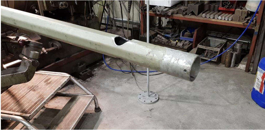
Mast verlenging wordt bewerkt voor montage seinra
