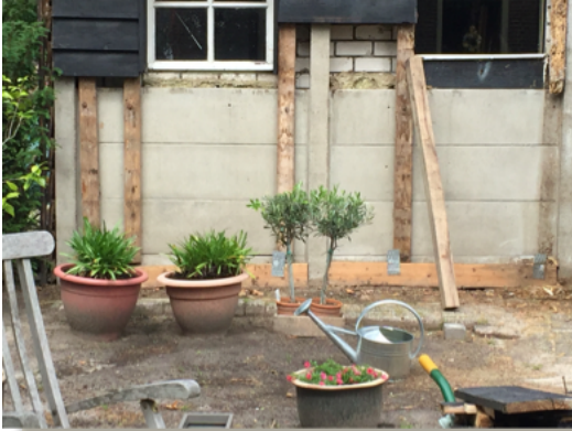
Eerst het rottende hout aan de buitenkant verwijderen.
