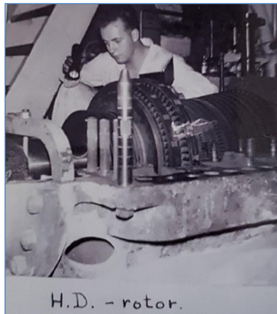
Turbine Survey a/b Overijssel bij HW. In Hamburg
