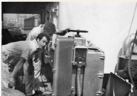
2e WTK Koen van Uitert en collega repareren een dekwinch - 1962
