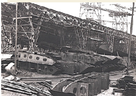
De bouw in volle gang - 1938
