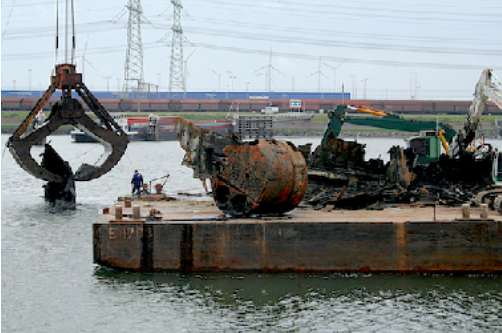
Een deel van de romp wordt boven water gehaald, een Schotse ketel ligt al op de lichter.
