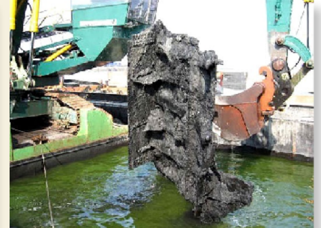
Een stuk van de dubbele bodem met dwars- en langsschotten.
