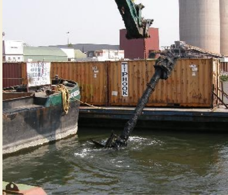
Een deel van de schroefas komt boven water.
