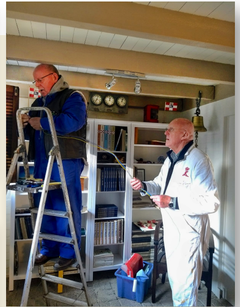
In de bibliotheek trekken Harry en Arie samen de electriciteitsdraden.
