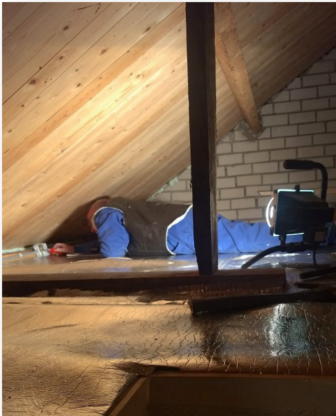
In een lasdoos op zolder klikt Harry van der Brugh de verschillende electriciteits-draden in de daarvoor bestemde lasklemmen.
