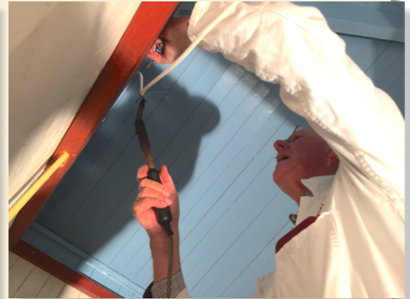
Arie de Waardt soldeert twee elektriciteitsdraden aan elkaar.
