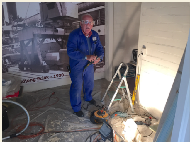
Een verraste Harry van der Brugh bezig met het aanleggen van stopcontacten en schakelaars.
