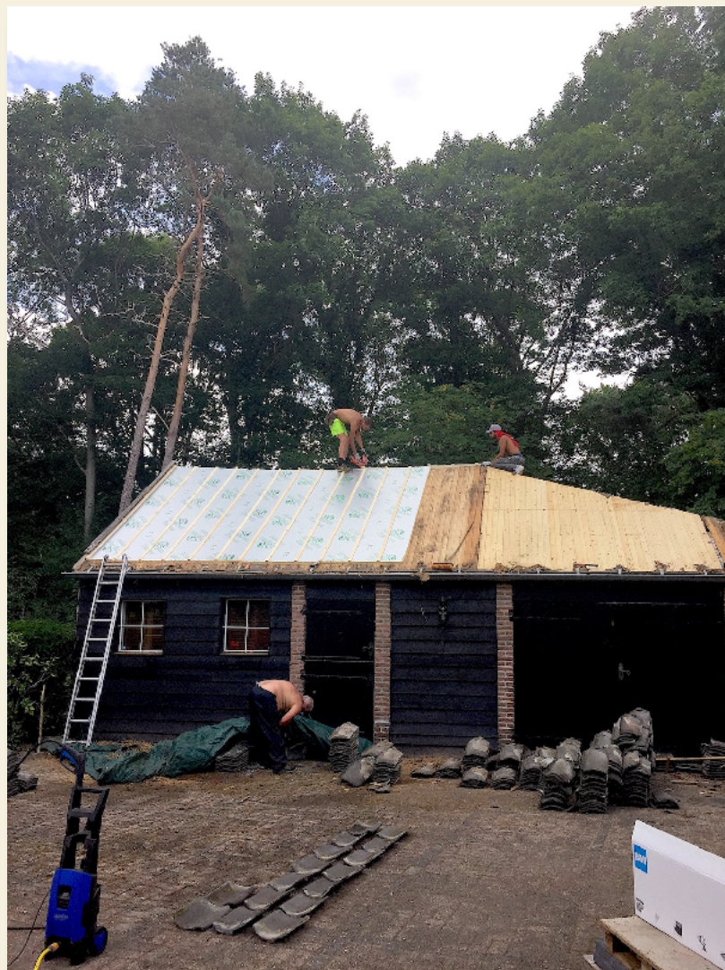
Vijf man sterk (drie op de foto) isoleren het dak van het Lloyd-Atelier (15 juni 2020)
